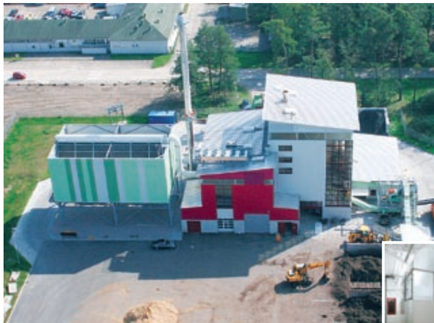
Innovative Energieversorgung: Biomassenkraftwerk Baden-Airpark
