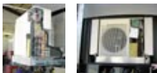
Beim DTM wird das Motorhome des HWA-Teams mit dem Mitsubishi Electric MXZ-System gekühlt und geheizt. Das Außengerät lässt sich ein- und ausziehen.
